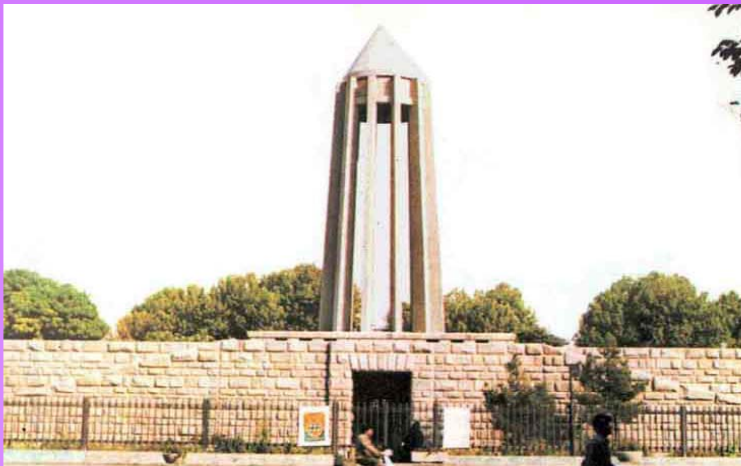
شکل ۳-۴- استفاده از گرانیت همدان در ساخت آرامگاه بوعلی سینا، دیواره، پله ها
