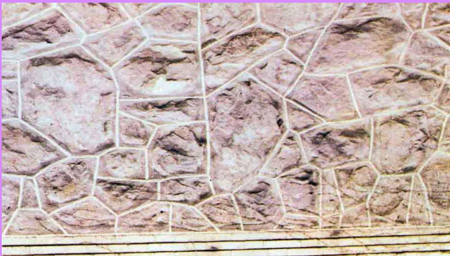
شکل ۲-۴ - استفاده از توفهای سبز برای ساخت دیوار منازل مسکونی
